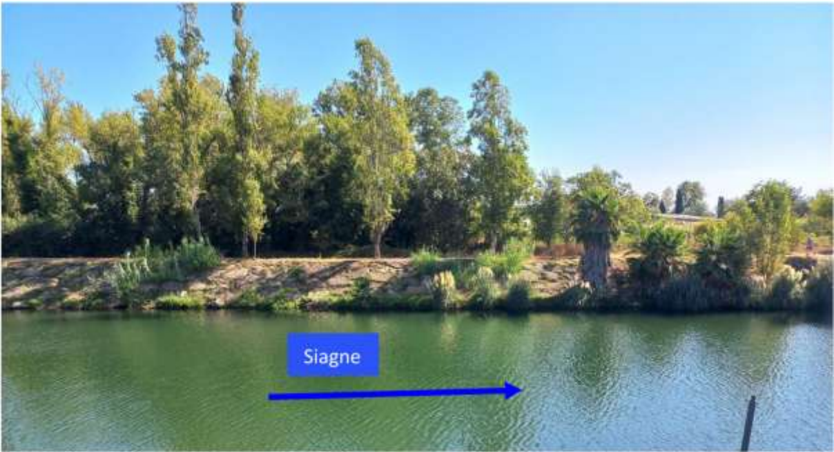
Photo 1 : Vues des berges enrochées en rive gauche de la Siagne (SUEZ Consulting, août 2024)
