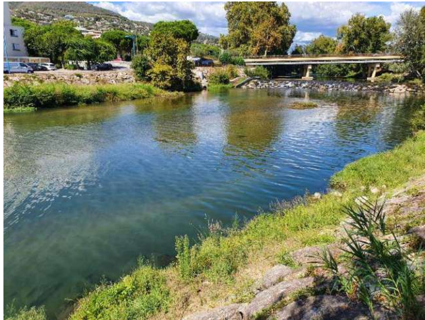
Le seuil, équipé en rive droite (à gauche) d'une passe à civelles (CINCLE, septembre 2021).
