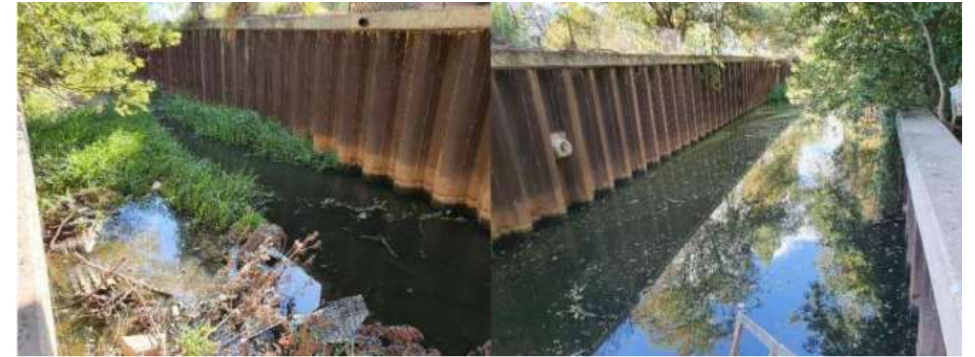
Partie en permanence en eau de la ROUBINE, entre rideaux de palplanches (CINCLE, septembre 2021)
