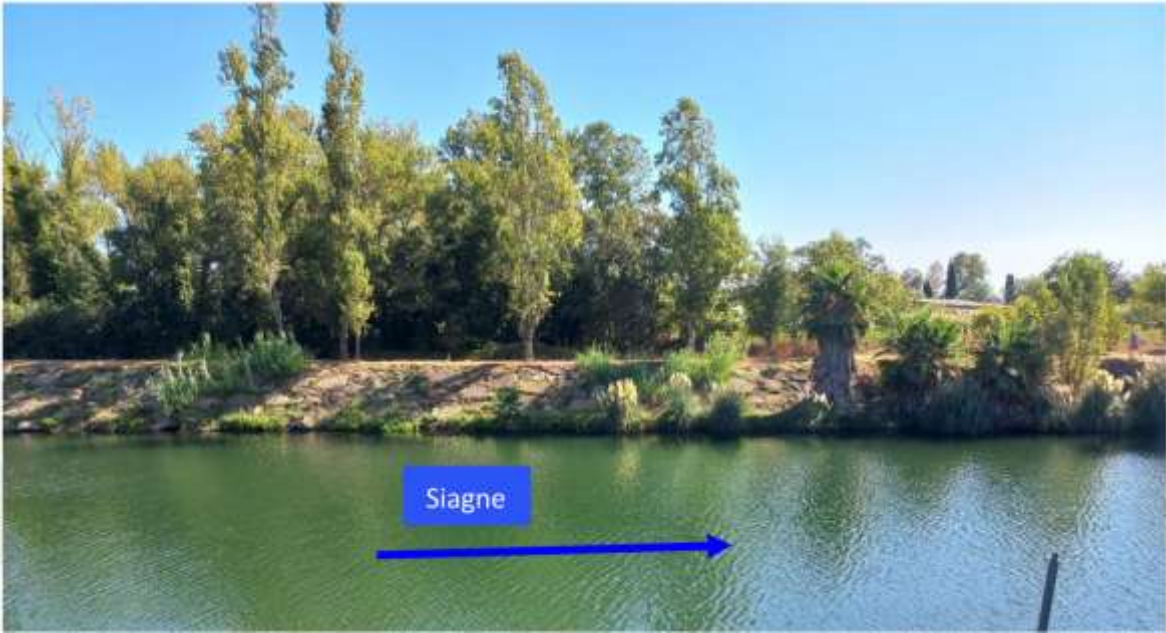
Vues des berges enrochées en rive gauche de la Siagne (SUEZ Consulting, août 2024)
