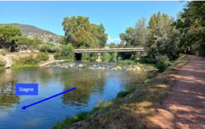
Vue du seuil anti-sel depuis l'aval en rive gauche de la Siagne (SUEZ Consulting, août 2024)
