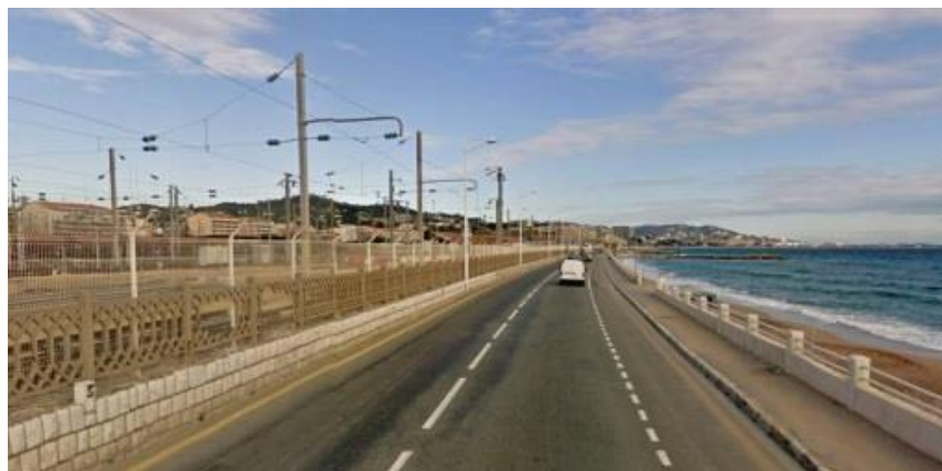
Figure 2 : Vue depuis la D6098 (source : Google Street View)
