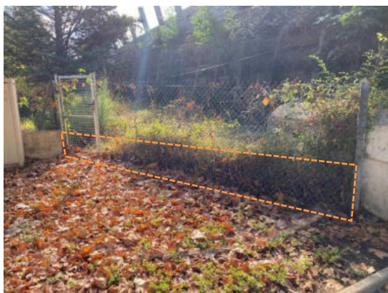
Figure 21 : Réhausse amont au niveau de la Chapelle Notre-Dame-des-Mimosas
