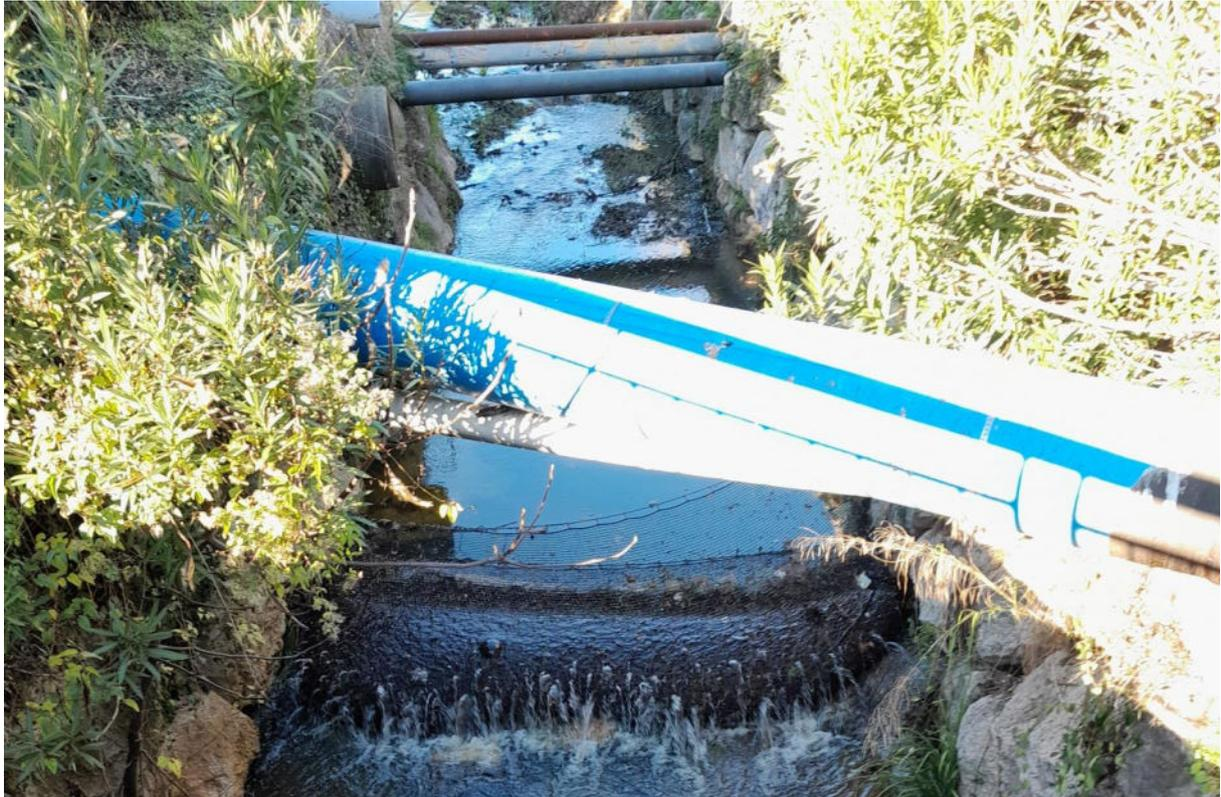
*Figure 3-31 : Piège à matériaux.*
