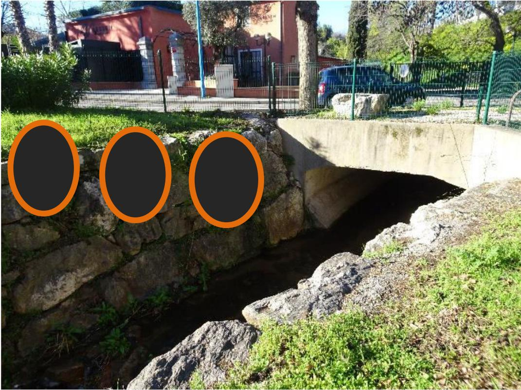
*Figure 3-27 : Sortie du passage busé de la Théoulière et position indicative de la sortie des buses*
