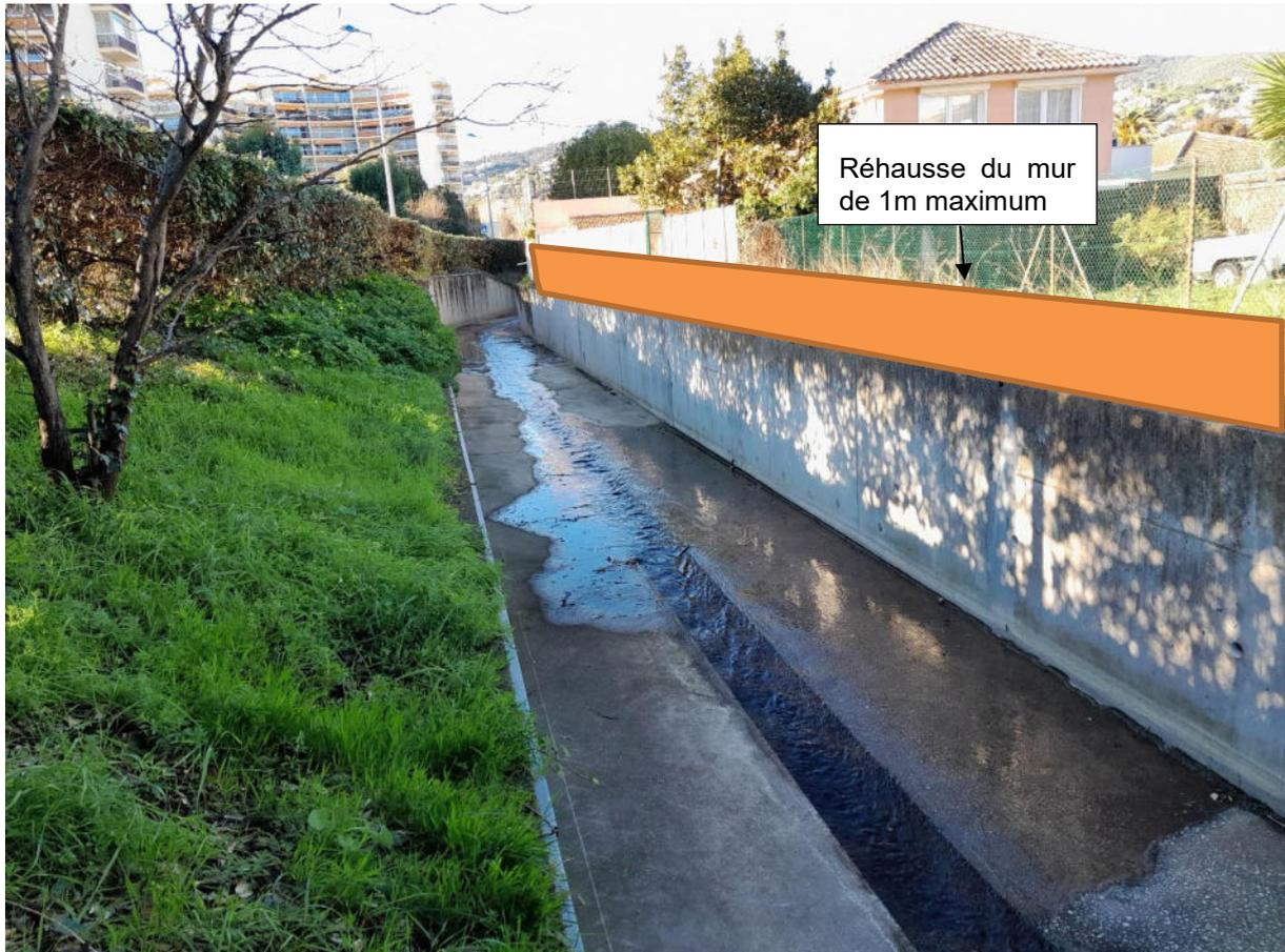
Figure 3-37 : Projection de l'aménagement du scénario 4
