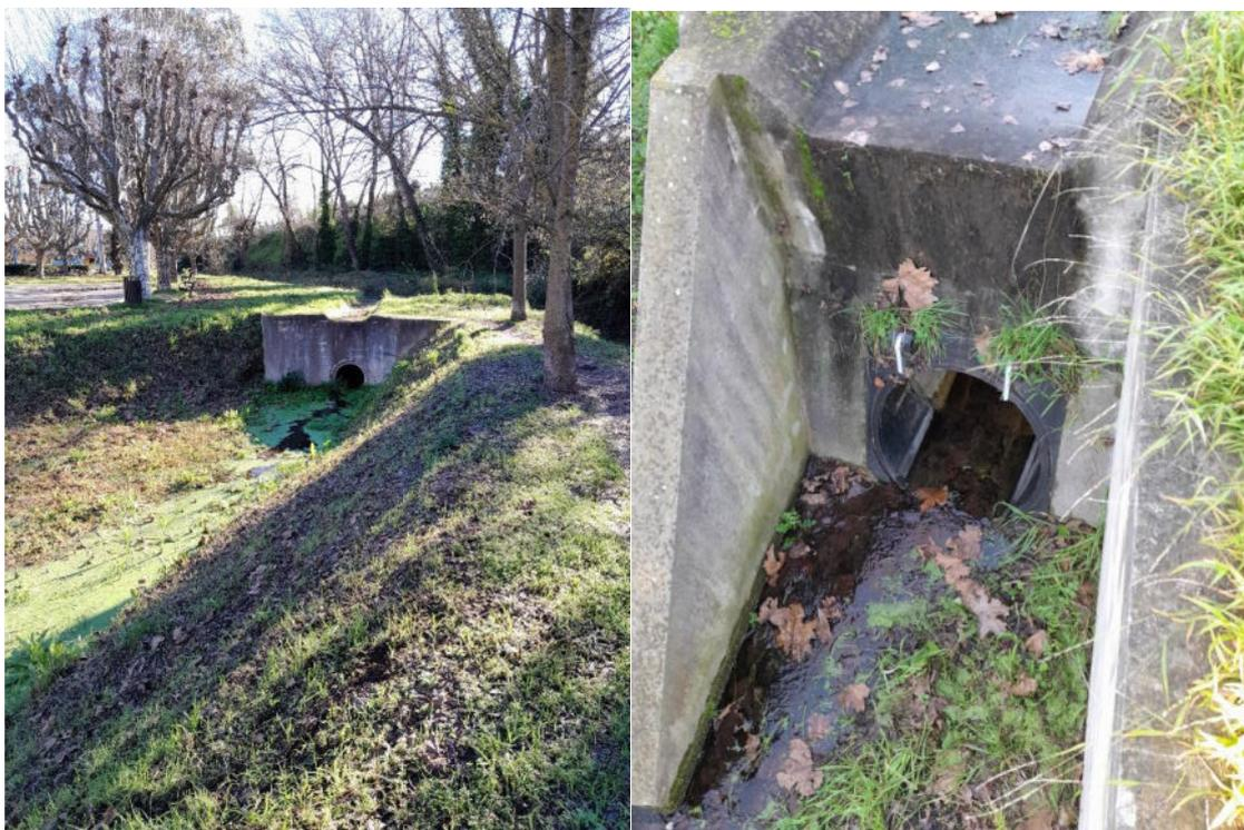
Figure 3-16 : Exutoire du bassin existant. A gauche : amont vu du bassin. A droite : aval vu de la Théoulière
