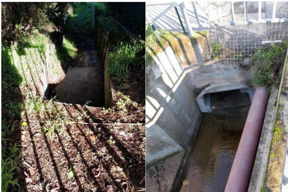
*Figure 3-8 : Etat de l'affluent amont à son exutoire. A gauche : en amont du passage sous le Chemin de la Théoulière. A droite : en aval du chemin*
