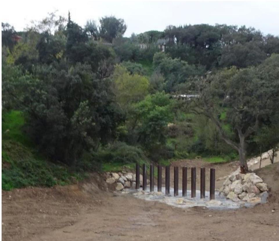
*Figure 3-2 : Arrivée dans le bassin de rétention*
