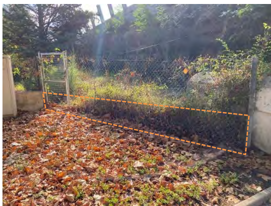
Figure 18 : Réhausse amont au niveau de la Chapelle Notre-Dame-des-Mimosas
