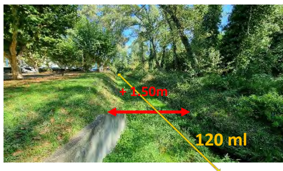
Figure 14 : Principe du recalibrage des berges de la Théoulière à l'aval du bassin
