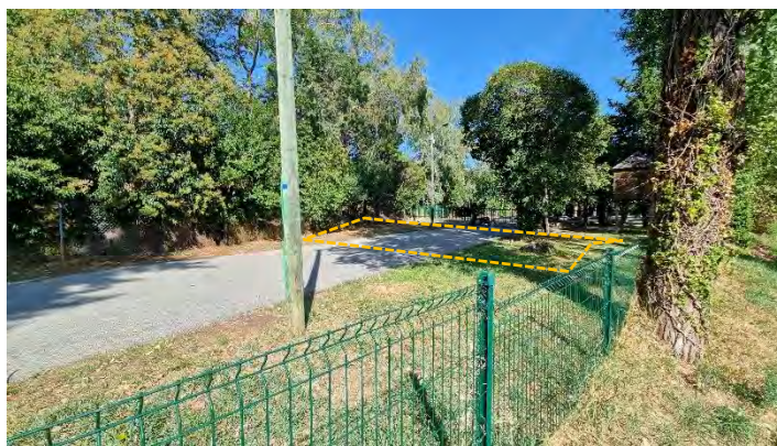
Figure 17 : Réhausse aval au niveau du skatepark
