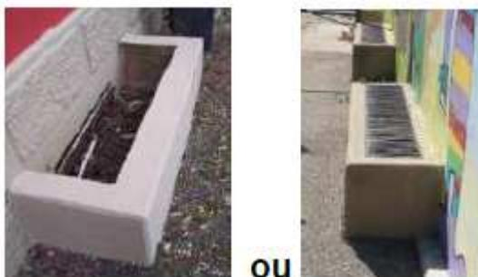
Figure 7 : Exemple de mur ceinturant/rehaussant les aérations
