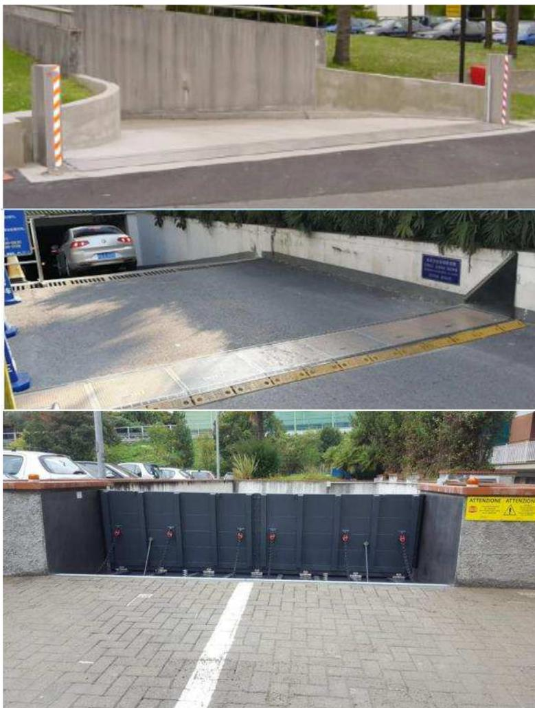
Figure 4 : Barrière passive encastrée/surélevée abaissée hors crue et barrière levée en crue (source : MSEI, ESTHI, 2 l'eau protection)
