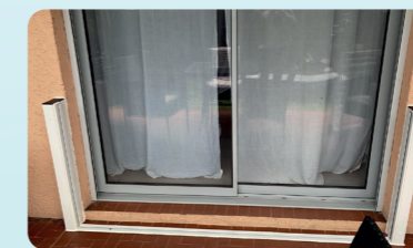
Batardeau posé devant l'ouverture, sur la façade extérieure
