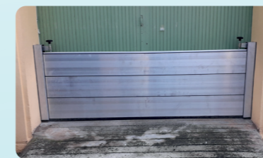
Batardeau installé entre deux murs
