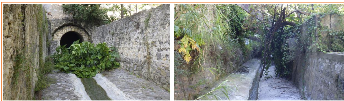
Figure 17 : illustration des risques liés à l'absence d'entretien des arbres qui peuvent constituer des embâcles et nuire au bon écoulement des eaux
