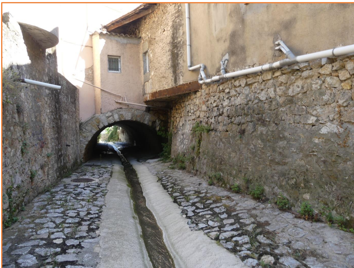
Figure 2 : Photo du Vallon sur la commune de Cannes – section ouverte en cadre U traversant un cadre
