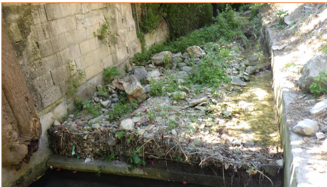
Figure 24 : illustration de dépôts sédimentaires retenus par un grillage installé dans le Vallon
