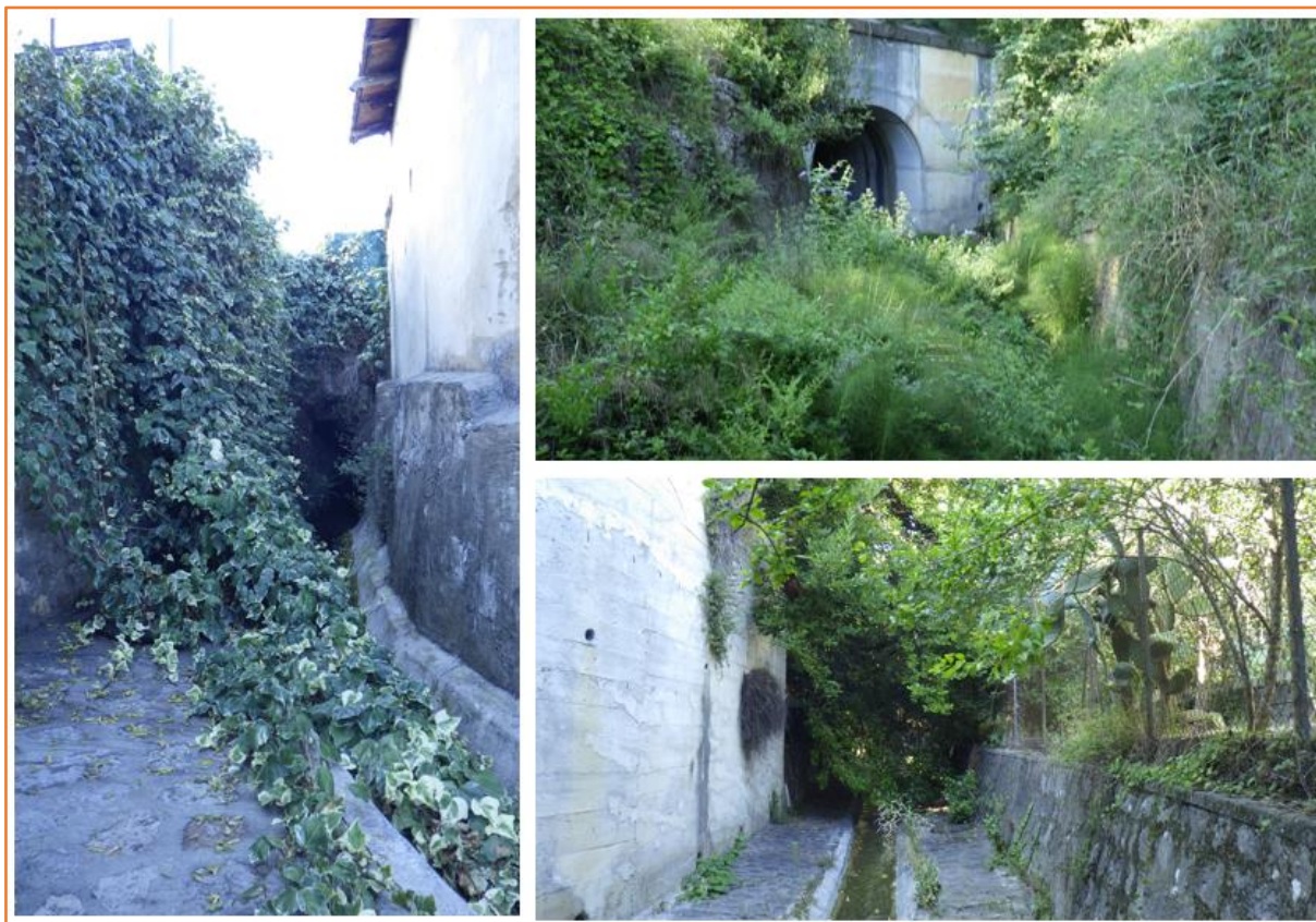
Figure 19 : secteurs à forte densité de végétation pouvant créer des obstacles à l'écoulement des eaux
