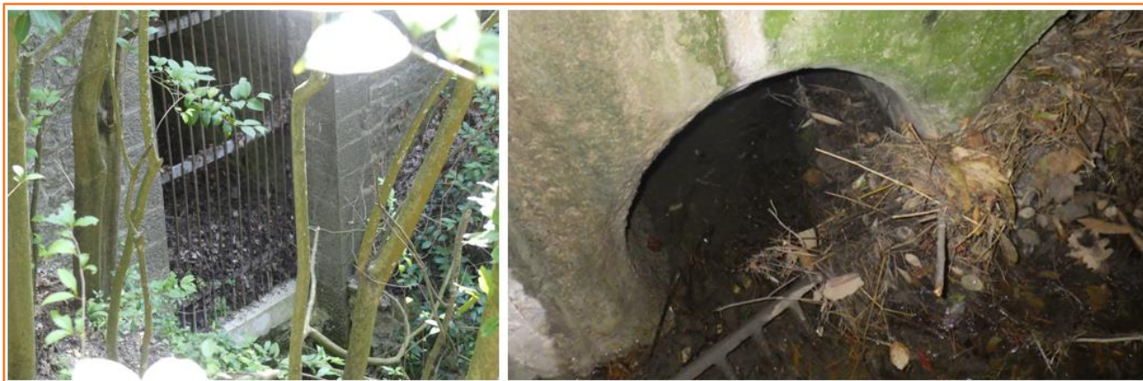
Figure 18 : illustration des risques de blocage ou de rupture d'ouvrage liés à l'accumulation de débris végétaux du fait du non-entretien de la végétation
