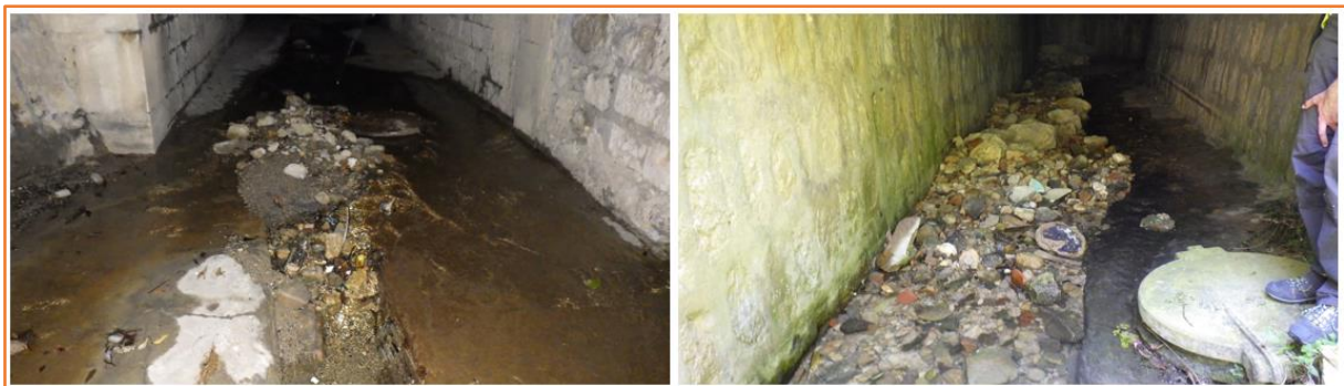
Figure 23 : dépôts sédimentaires constatés sur les sections couvertes du Vallon
