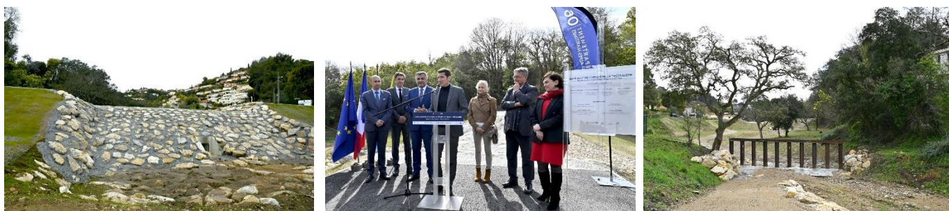
A gauche, le barrage du bassin de rétention de la Théoulière. Au centre, discours de David Lisnard. A droite, le piège à embâcles © CACPL
