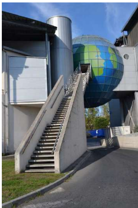
Centre de Tri des emballages de Cannes
