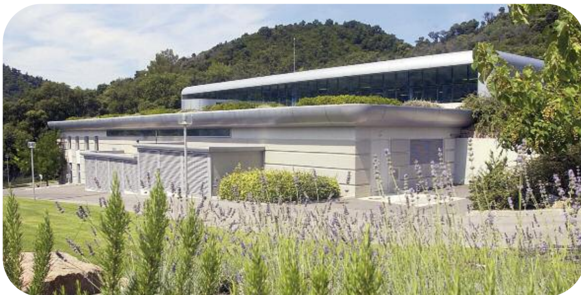
Apié - Usine d'ultrafiltration
