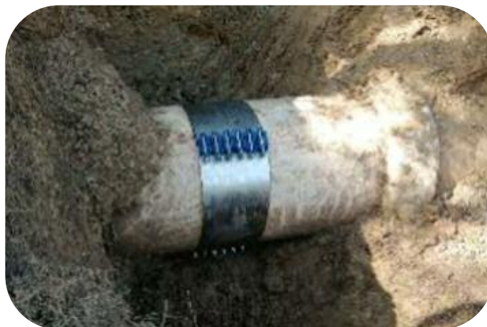
Pose d'un rockwell
