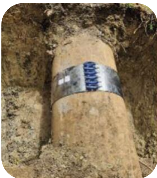
Pose d'un rockwell
