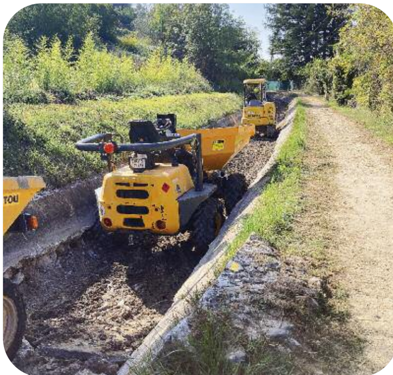
Renouvellement de 81 mètres du Canal de la Siagne, chemin de Saurin à Mouans Sartoux
