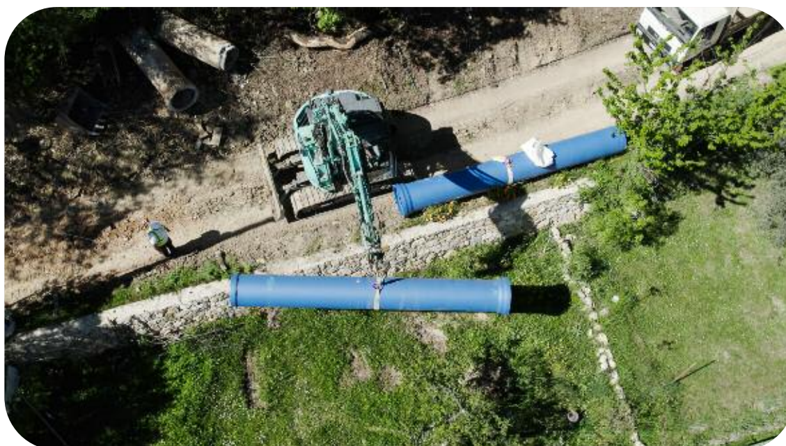
Travaux de renouvellement de 210 mètres du canal du Loup à Le Bar sur Loup
