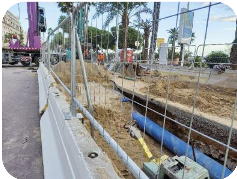
Renouvellement de 1,2 km DN 400 du réseau d'eau potable, chaussée nord du boulevard de la Croisette à Cannes
