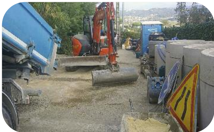
Renouvellement de 250 mètres du réseau d'eau potable, boulevard Valmajour à Mandelieu
