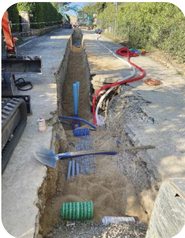
Renouvellement de 800 mètres du réseau d'eau potable, Chemin des Cabrières à Mougins
