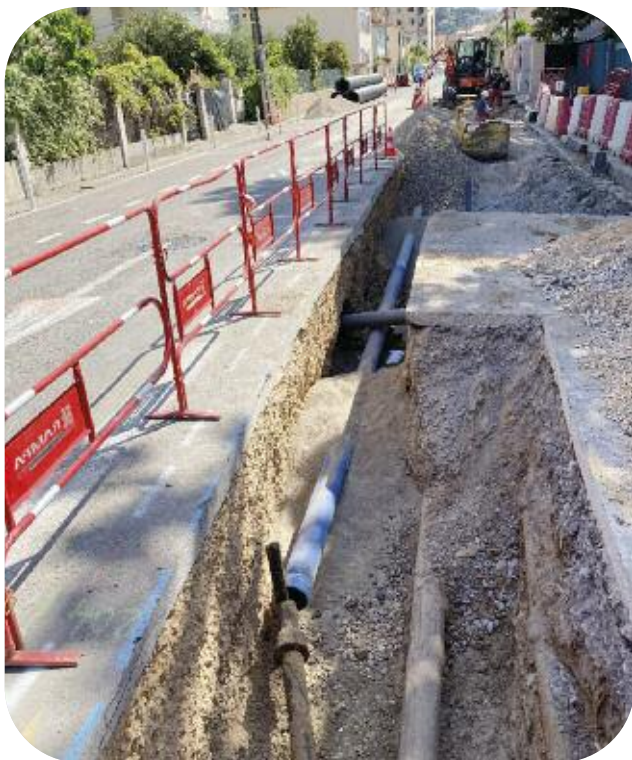
Renouvellement de 300 mètres du réseau d'eau potable, boulevard de la Mourachonne à Pégomas
