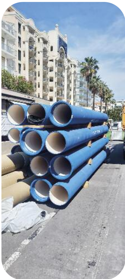
Renouvellement de 1,2 km DN 400 du réseau d'eau potable, chaussée nord du boulevard de la Croisette à Cannes
