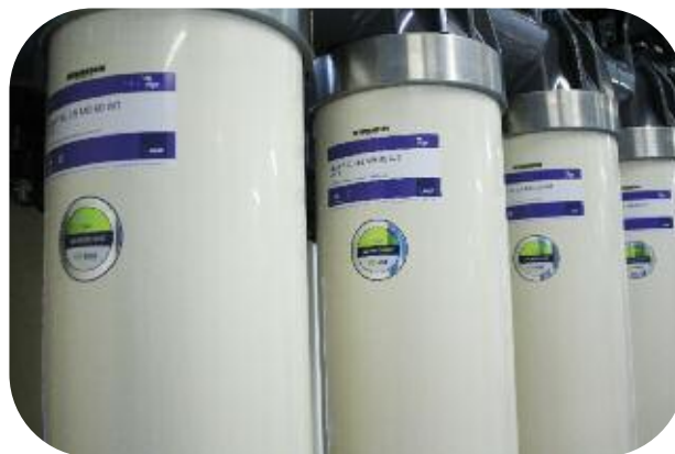
Mars 2017 - changement des membranes d'ultrafiltration
