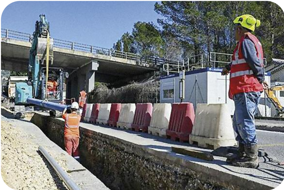
Renouvellement du réseau d'eau potable, Chemin de la Plaine à Mougins
