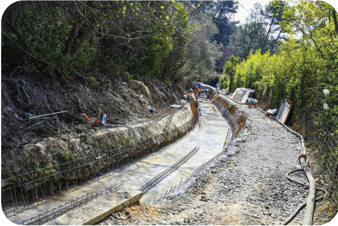
Renouvellement du canal de la Siagne, Chemin de Saurin à Mouans Sartoux
