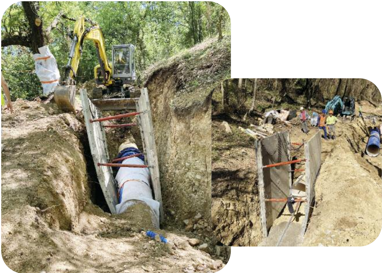
Renouvellement de 210 mètres du Canal du Loup, chemin du château d'eau à Le Bar-sur-Loup
