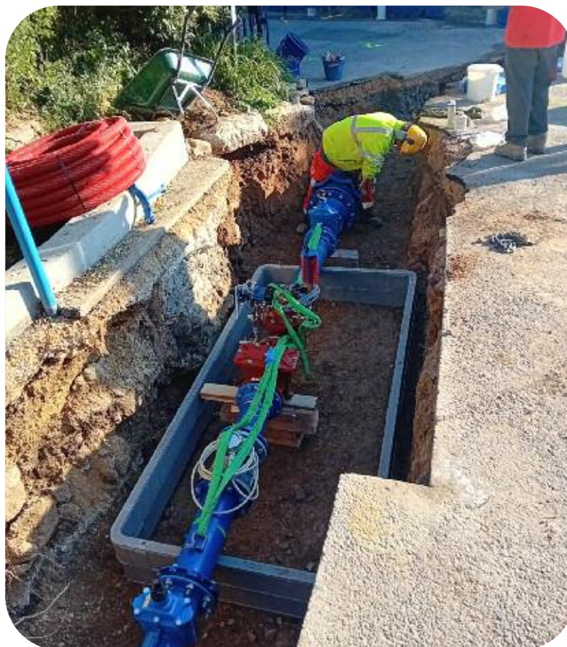
Installation d'équipements hydrauliques sur 13 sites afin de réduire les pressions de service à Mandelieu
