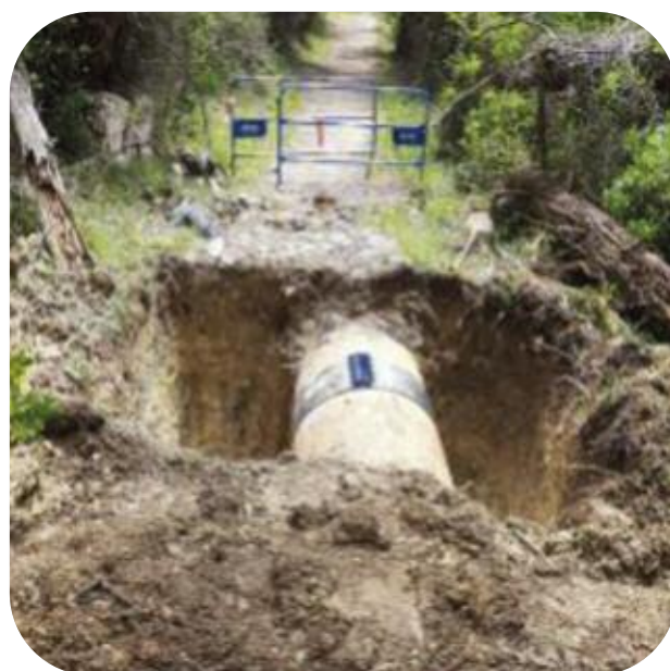
Réparation terminée, chantier sécurisé
