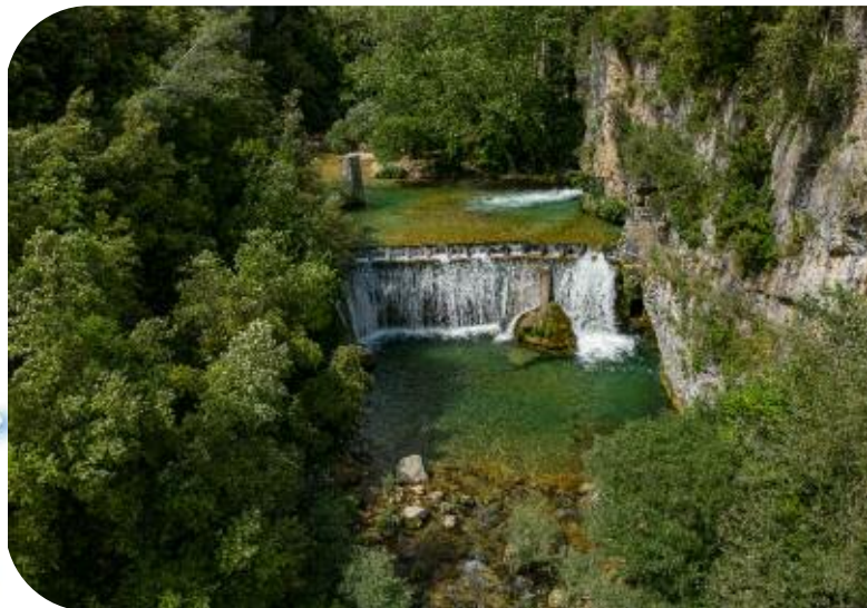
Barrage de Saint-Cézaire-sur-Siagne
