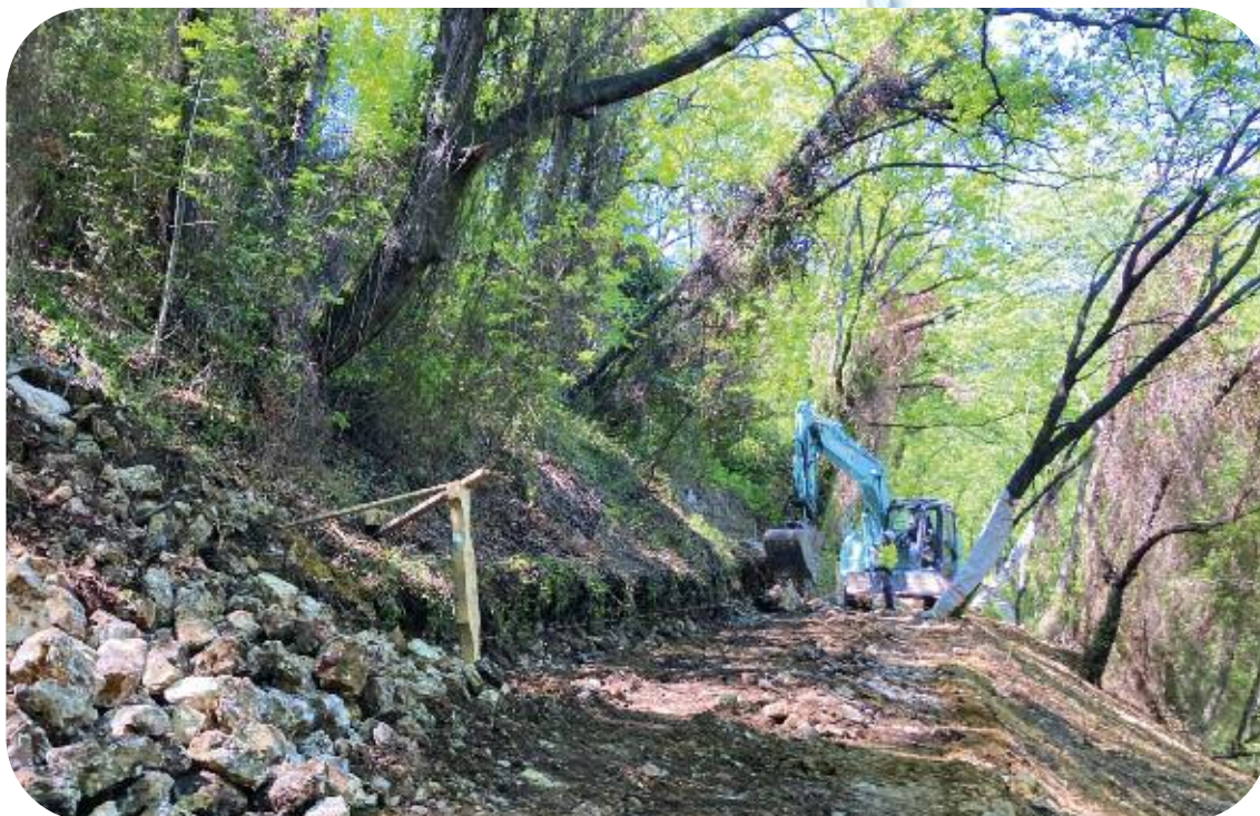
Travaux de renouvellement du canal du Loup
