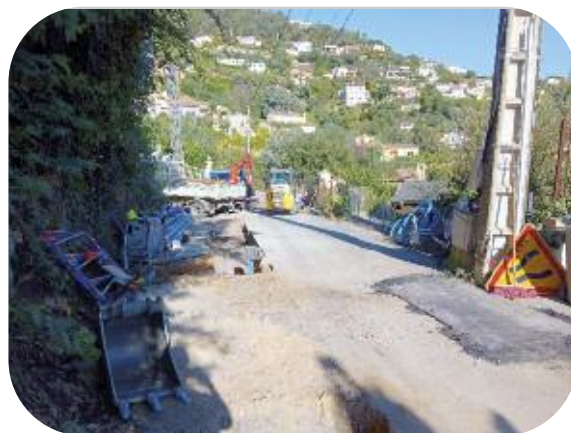
Renouvellement de 250 mètres du réseau d'eau potable, boulevard Valmajour à Mandelieu
