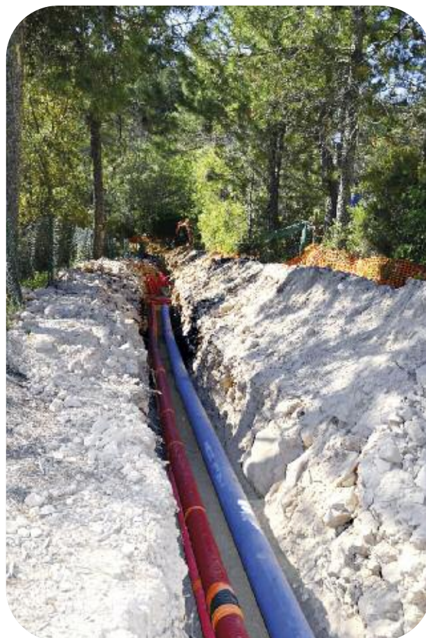
Renouvellement et création de réseau d'eau potable, boulevard des Alpes à Théoule-sur-Mer
