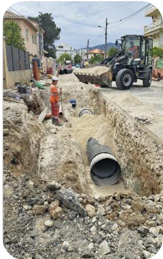
Renouvellement de 320 mètres du réseau d'eau potable, avenue des Mûriers à Cannes
