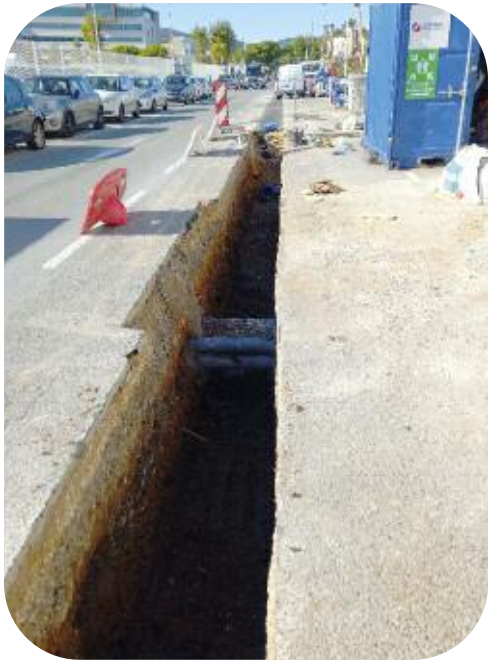
Renouvellement de 350 mètres du réseau d'eau potable, allée des Gabbians à Cannes
