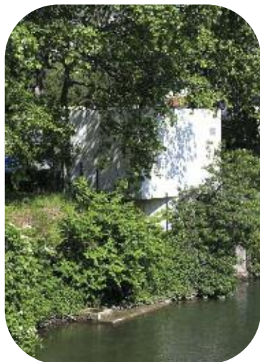
Prise d'eau de la Siagne
