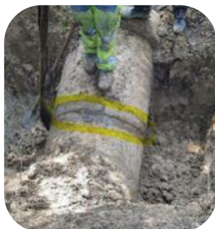
Pose d'un rockwell
