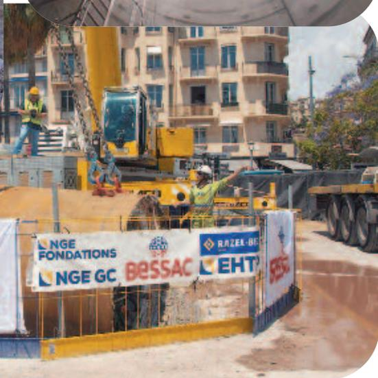
*Travaux de renouvellement des réseaux d'assainissement avec le microtunnelier boulevard de La Croisette à Cannes*
