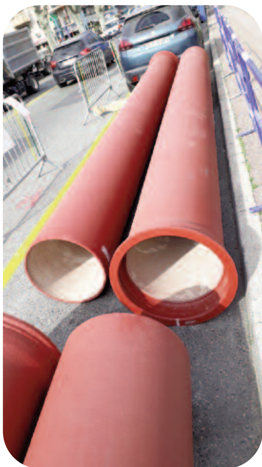
Canalisations de collecte des eaux usées
