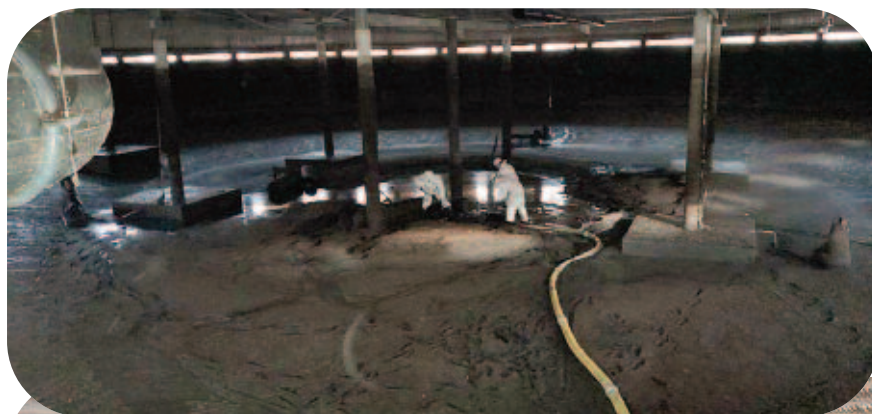
Curage du bassin temps de pluie N°2 - Avant nettoyage
