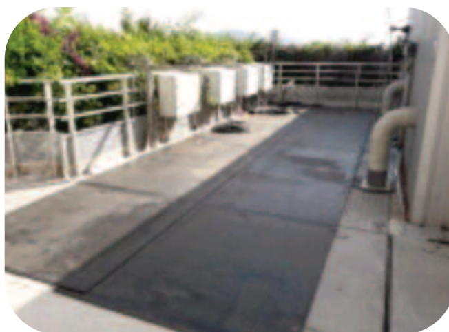
Géotextile (bidim®) sur le poste de relevage des eaux brutes
