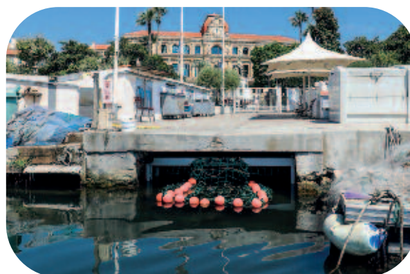
Pose d'un filet anti micro-déchets (mailles de 1mmx1mm retenant jusqu'aux mégots de cigarettes, billes de polystyrène...) le 16 juillet 2020 sur un émissaire en mer en sortie de vallon du Poussiat dans le Vieux Port de Cannes. Une action concrète et inédite en milieu portuaire sur le territoire national qui s'inscrit dans le programme de préservation de la qualité des cours d'eau et des eaux de baignade, piloté par l'Agglomération Cannes Lérins.
