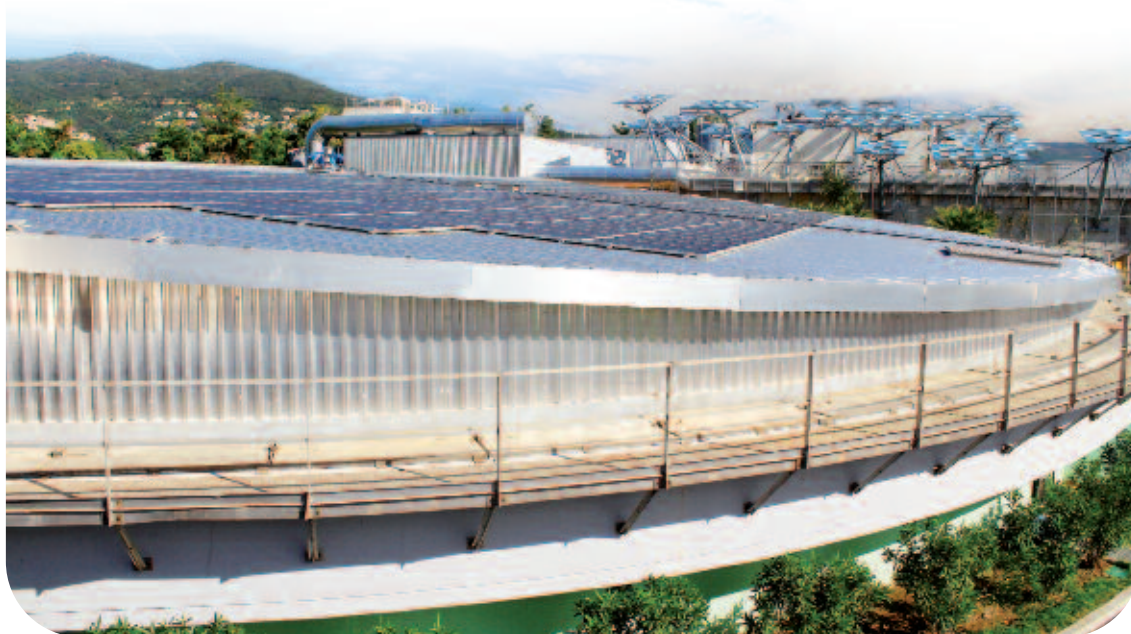
Aquaviva – équipement de panneaux photovoltaïques
