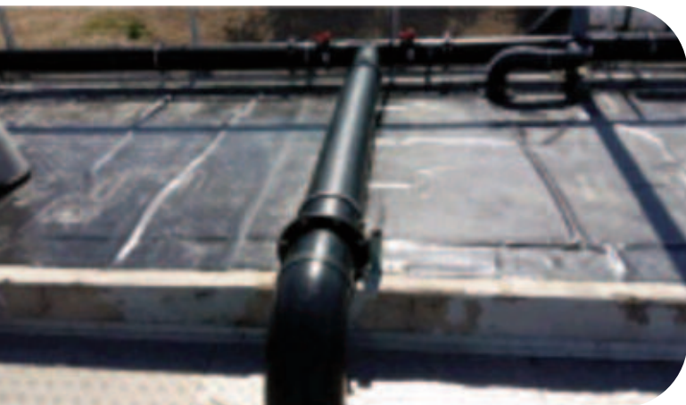
Bidim® posé sur les trappes d'arrivée des effluents de la station
