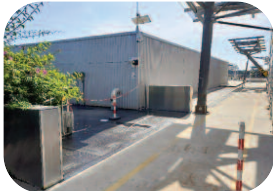
Création et mise en place des batard'air
