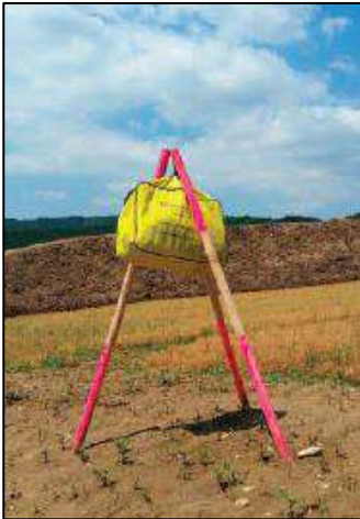
Figure 61 : Exemple de kit anti-pollution isolé du sol (Guide technique "Protection des milieux aquatiques en phase chantier", AFB, 2018)
