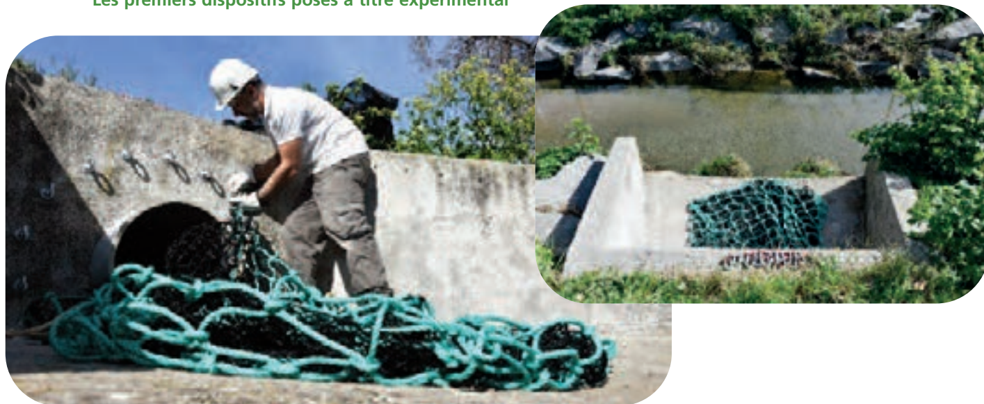
4 mars 2020 : pose du premier filet anti macro déchets sur l'exutoire d'une canalisation d'eaux pluviales se déversant dans le cours d'eau de la Frayère. Cannes La Bocca face à la piscine Grand Bleu.
