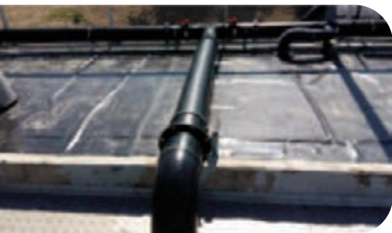
Bidim® posé sur les trappes d'arrivée des effluents de la station
