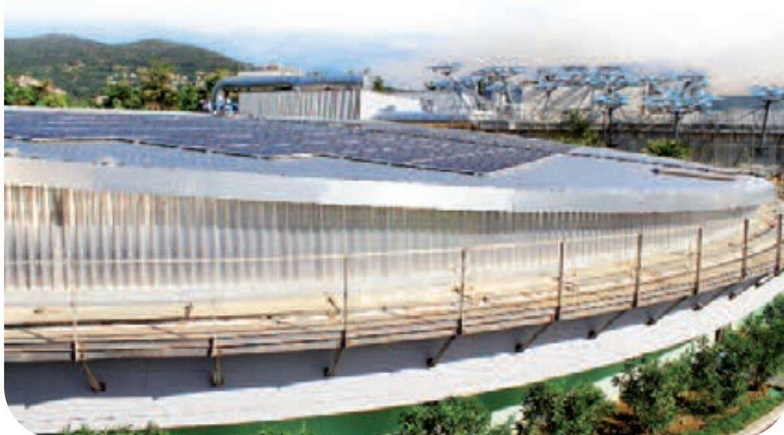
Aquaviva – équipement de panneaux photovoltaïques
