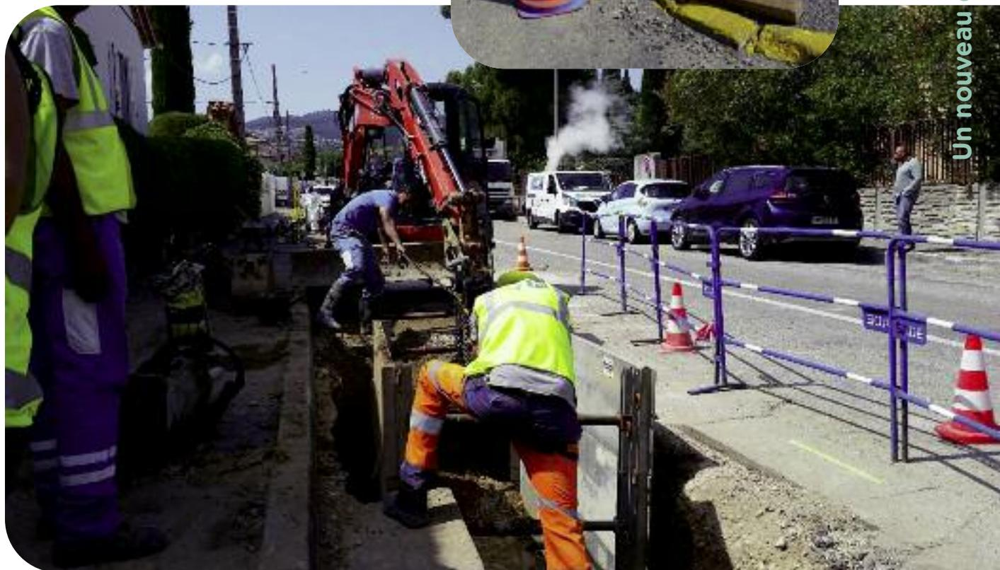
*Renouvellement de 550 mètres de réseaux d'eaux usées et d'eaux pluviales Bd Jean St-Martin.*
