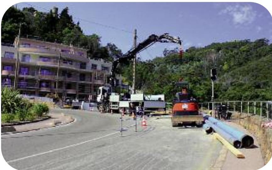
*Extension des réseaux d'eaux usées et d'eaux pluviales pour le raccordement du projet immobilier Corniche d'Or.*
