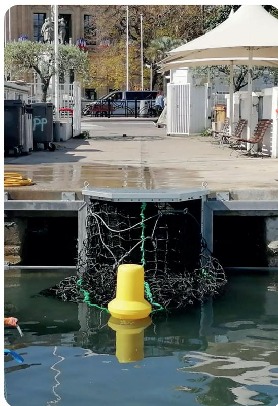
*Pose d'un filet anti micro-déchets (mailles de 1mmx1mm retenant jusqu'aux mégots de cigarettes, billes de polystyrène...) sur un émissaire en mer en sortie de vallon du Poussiat dans le Vieux Port de Cannes.*
