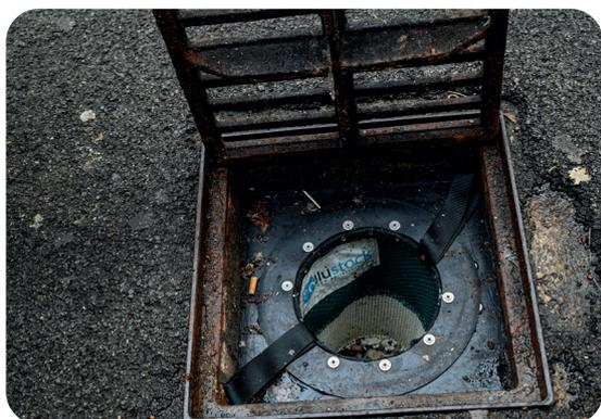
En 2024, pose de filets de récupération des déchets dont l'installation d'un filet cadre débrayable sur le vallon de la Foux.
